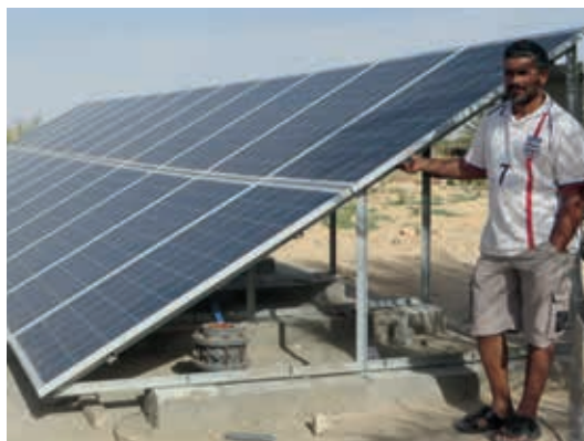
Bewässerung von Dattelpflanzungen im Süden von Tunesien mithilfe einer Photovoltaik-Lösung.
